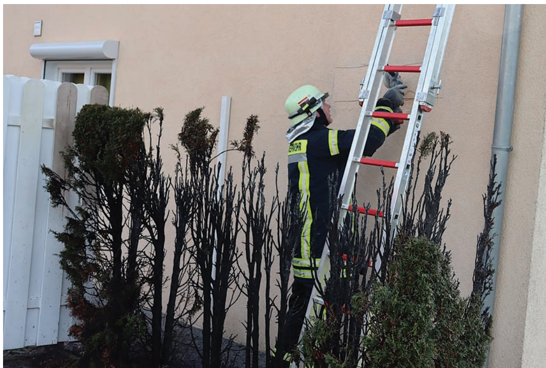
Ein Kamerad der Ortsfeuerwehr sucht am Wärmeverbundsystem an der Hauswand nach möglichen Glut- nestern.
